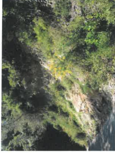
Zone éboulée en bord de route : vallon du Terrain
